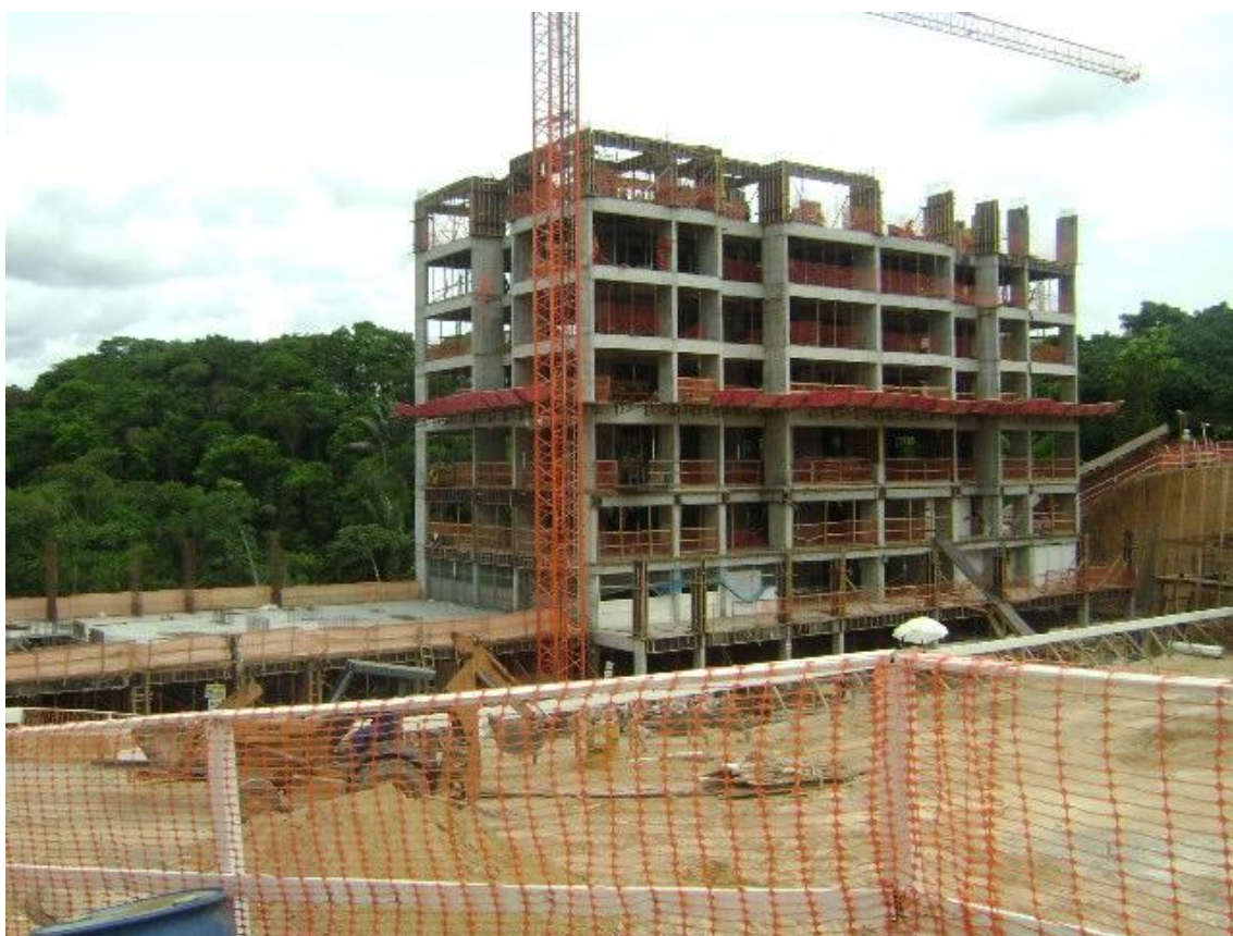
Foto 01: Torre 1 (proteção com bandeja)
